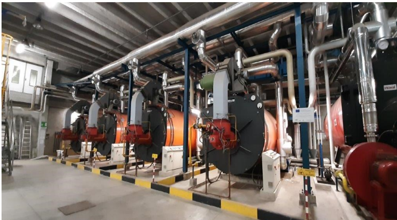
Figura 3.1 – Edificio centrale – Caldaie installate all'epoca di costruzione della centrale
