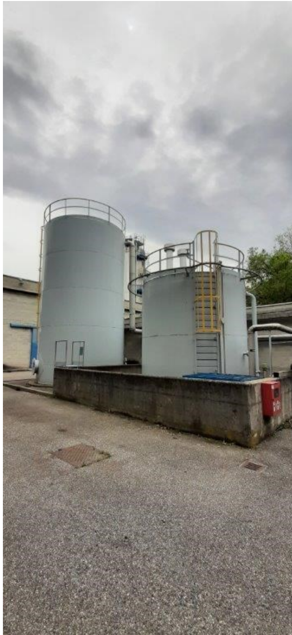
Figura 3.1 – Aree esterne Serbatoio riserva idrica antincendio
