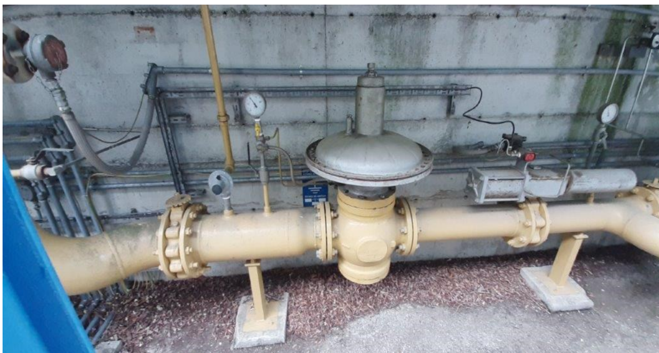
Figura 3.2 – Aree esterne – Riduttore pressione gas naturale caldaie
