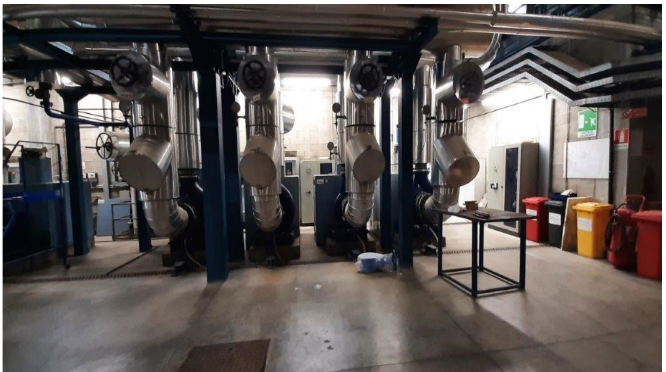
Figura 3.1 – Edificio centrale – Pompe rete teleriscaldamento (secondo stadio)
