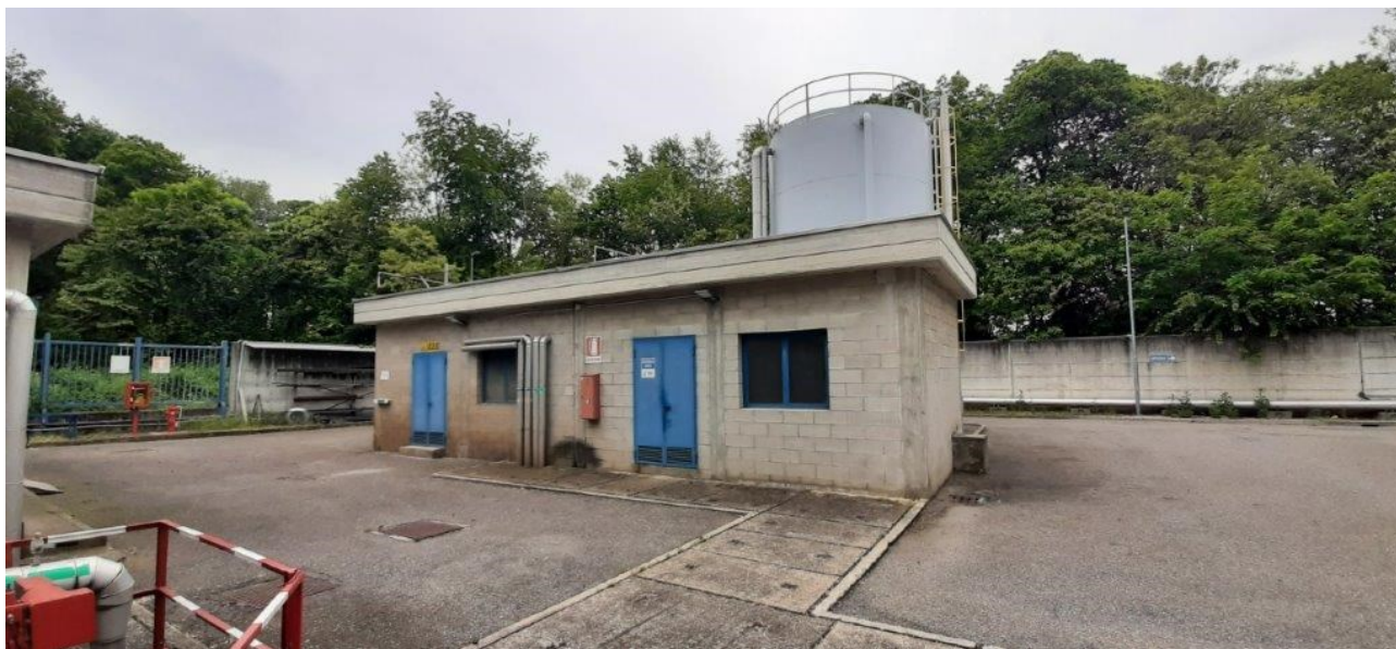
Figura 3.1 – Aree esterne – Serbatoio gasolio e locale pompe gasolio
