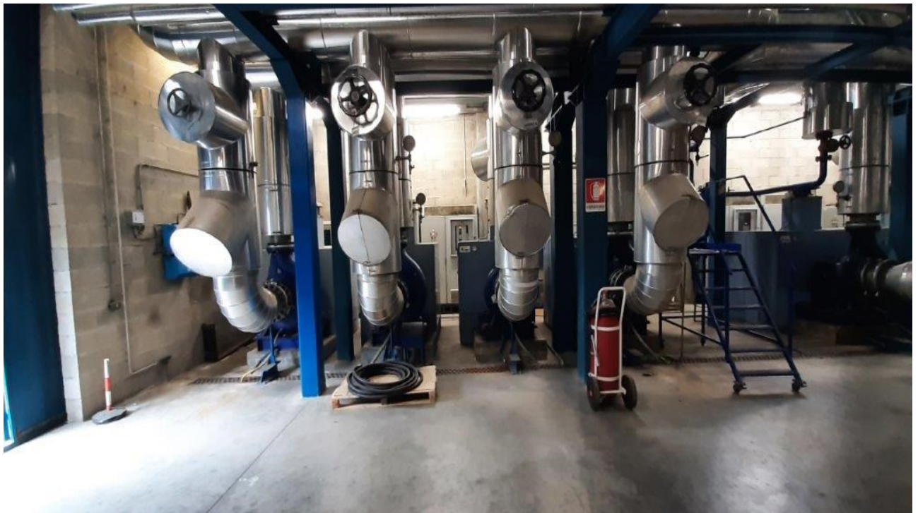
Figura 3.1 – Edificio centrale – Pompe rete teleriscaldamento (primo stadio)
