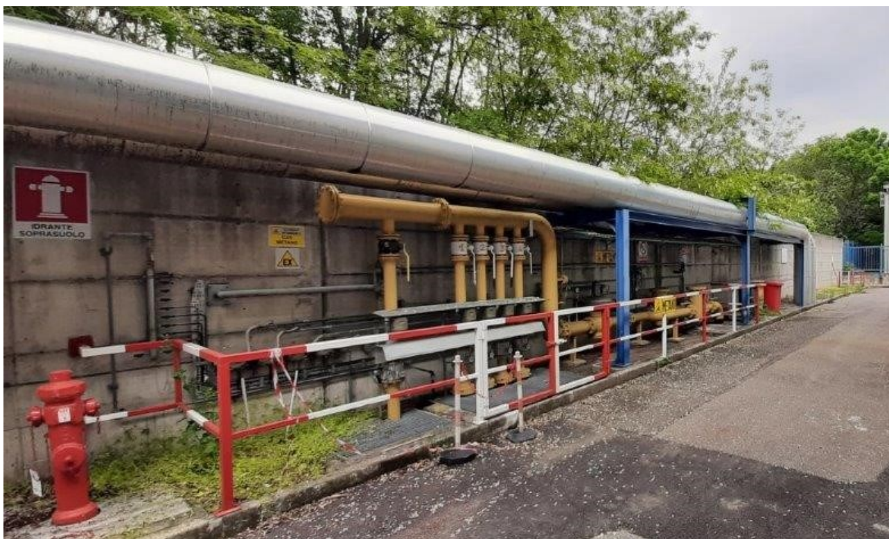
Figura 3.1 – Aree esterne – Alimentazione gas naturale caldaie
