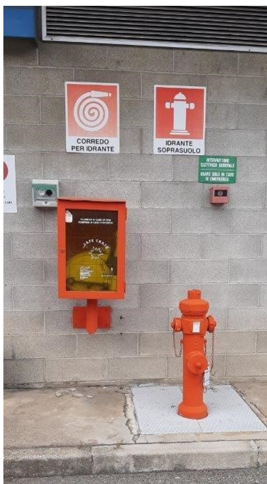
Figura 3.2 – Aree esterne – Tipico idrante presente all'interno della centrale
