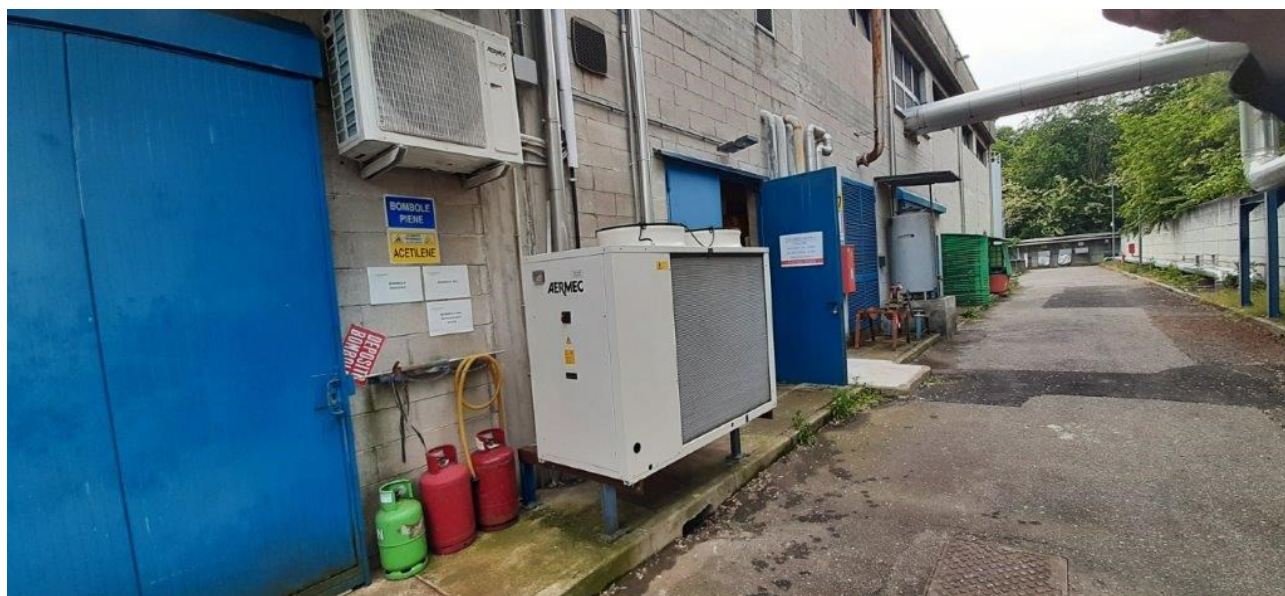
Figura 3.2 – Aree esterne – Frigorifero impianto condizionamento uffici
