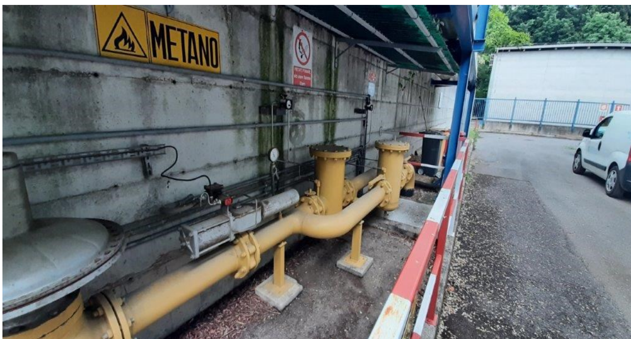
Figura 3.2 – Aree esterne – Filtri gas naturale caldaie
