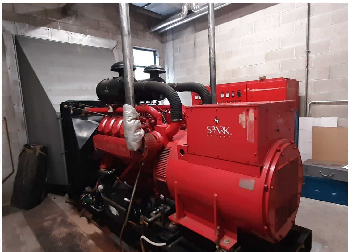
Figura 3.1 – Edificio centrale – Gruppo elettrogeno di emergenza
