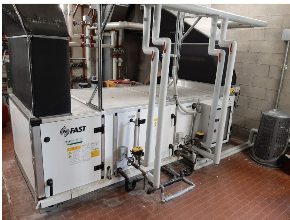
Figura 3.1 – Edificio centrale – Unità di trattamento dell'aria
